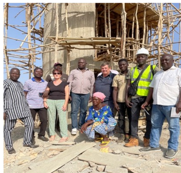
château d'eau de Pingou
