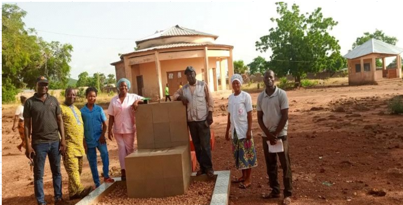
Poste d'eau autonome au centre de soins de Nodi
