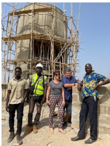
Château d'eau en chantier
